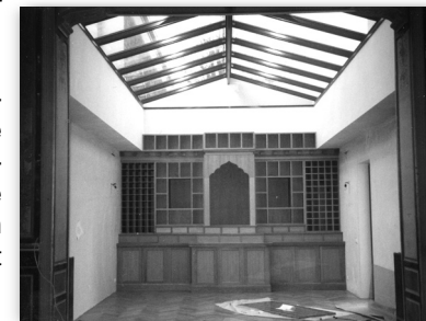
Nouveau temple en construction New temple under construction Nieuwe temple in aanbouw
